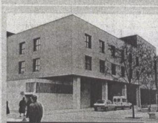
Fachada del centro cívico Zona Sur. EL NORTE
